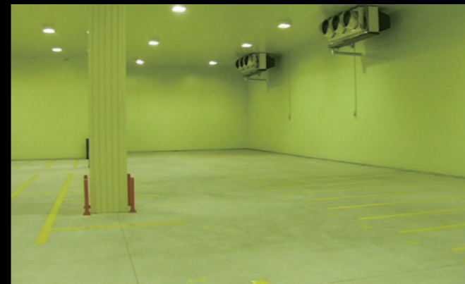
大型冷凍及び冷蔵庫工事
