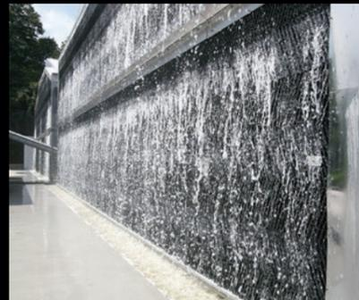
粉塵飛散防止及び脱臭用シャワーストフィルター
