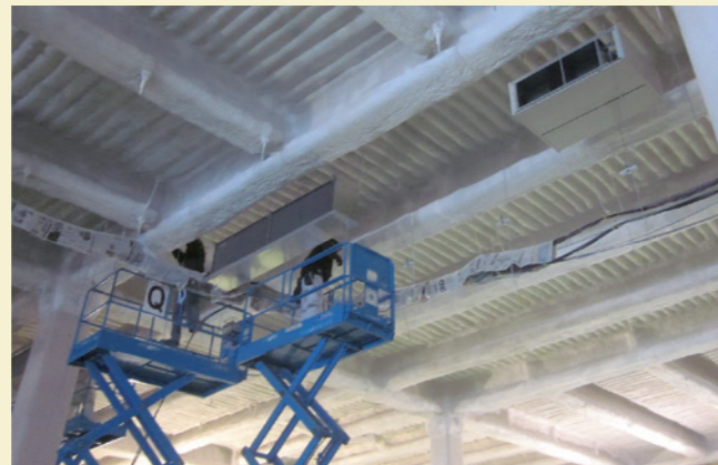
ウレタン吹付工事
