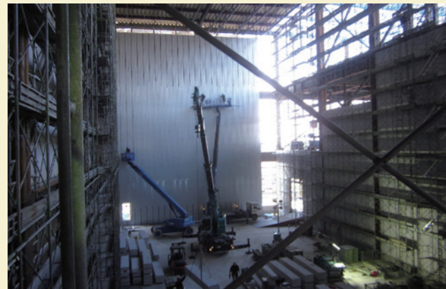
大型倉庫のパネル工事
